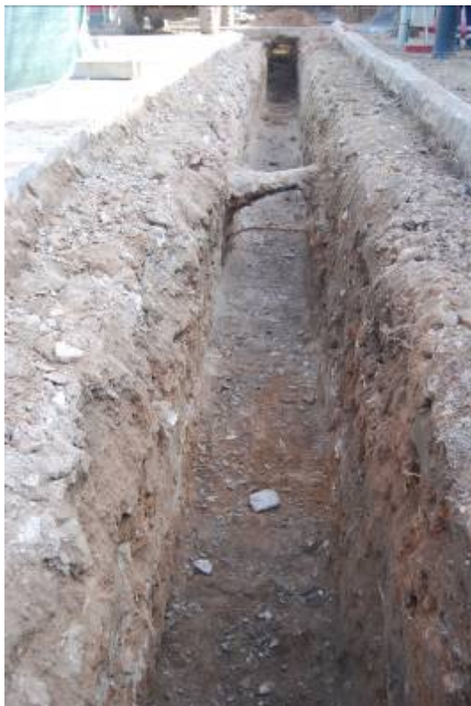
Fotografia núm. 68: vista de la rasa 7000
