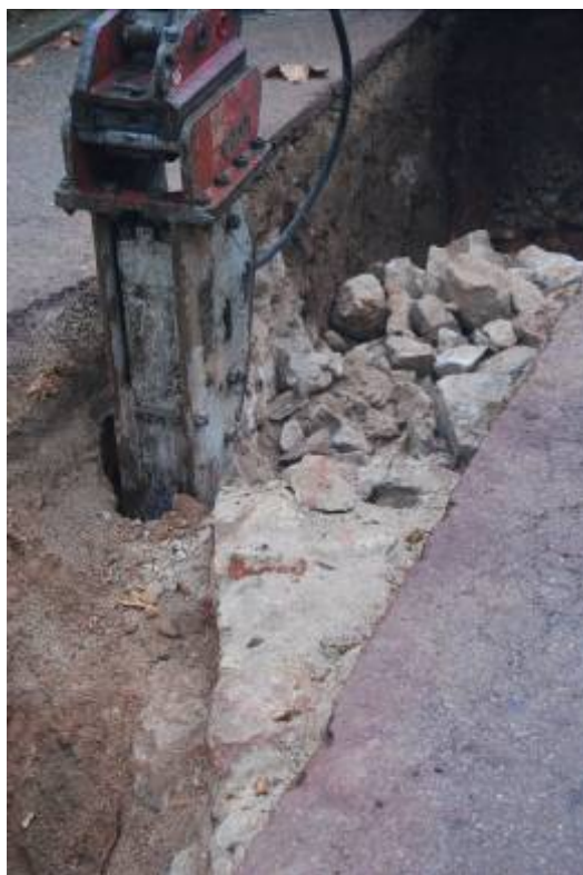
Fotografia núm. 59: desmuntatge de la UE 5003
