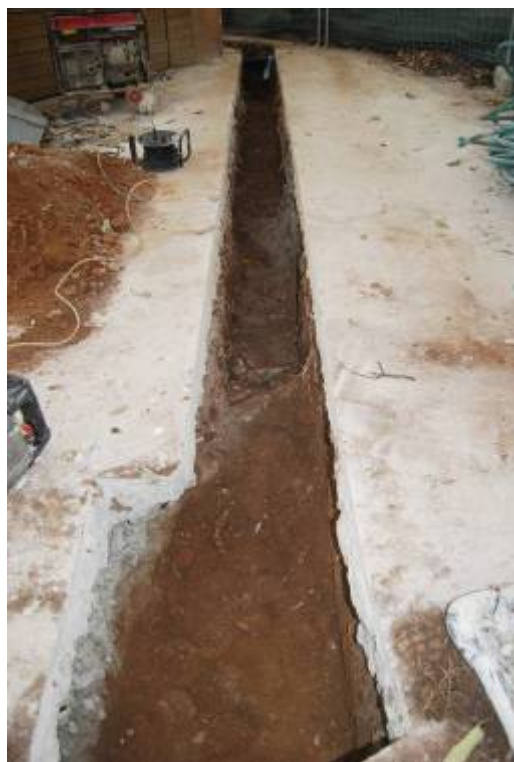
Fotografia núm. 28: vista de la rasa 2000
