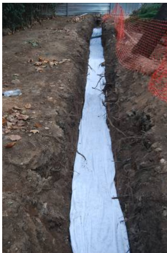
Fotografia núm. 50: cobertura de les estructures a la rasa 4000
