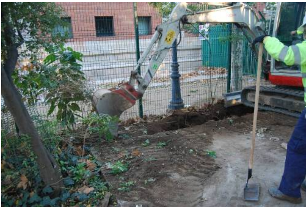
Fotografia núm. 15: obertura de la rasa 1000
