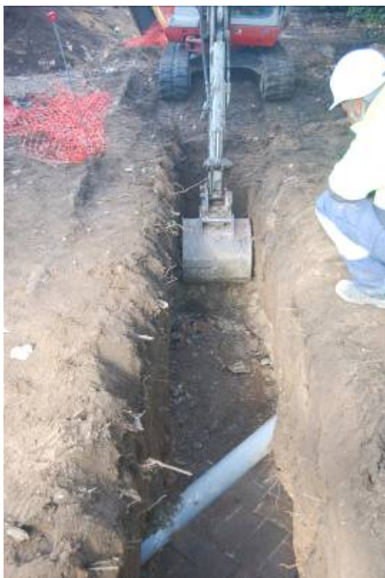
Fotografia núm. 38: obertura de la rasa 4000
