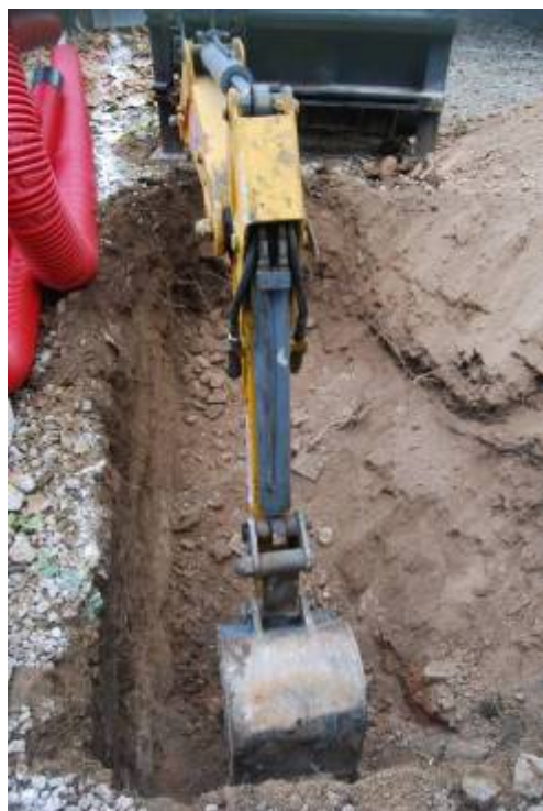
Fotografia núm. 2: obertura de la cala 100
