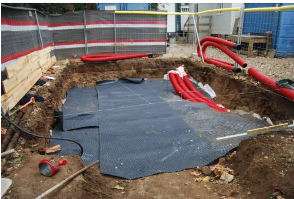
Fotografia núm. 12: cobertura de les estructures amb planxa de plàstic
