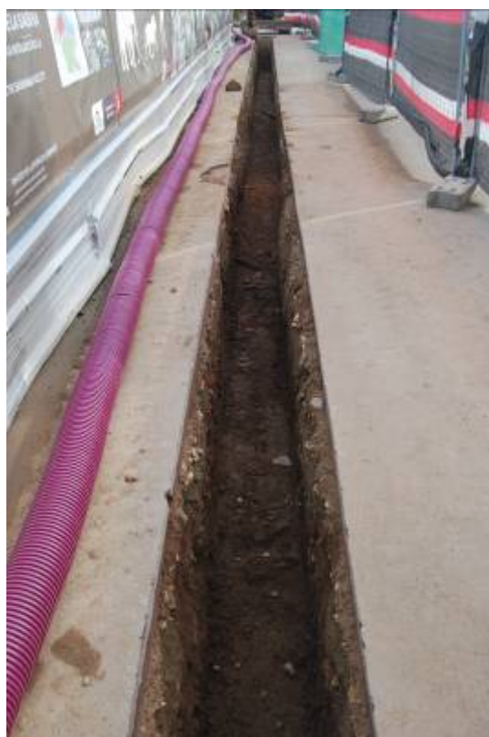
Fotografia núm. 63: vista de la rasa 6000
