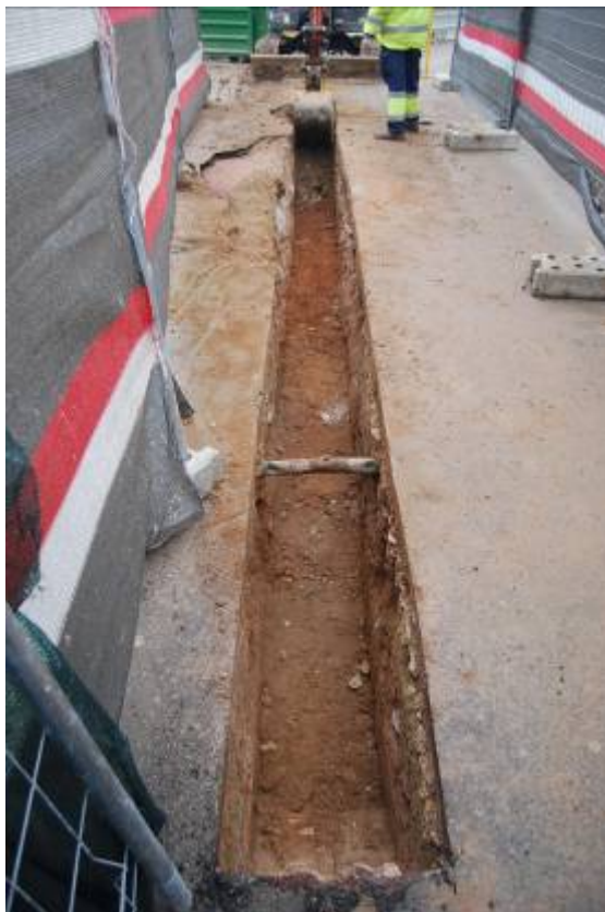
Fotografia núm. 62: obertura de la rasa 6000
