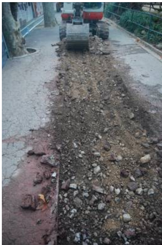
Fotografia núm. 54: obertura de la rasa 5000
