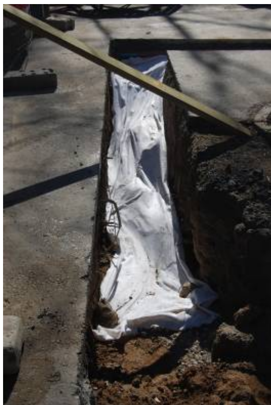
Fotografia núm. 52: cobertura de les estructures a la rasa 4000
