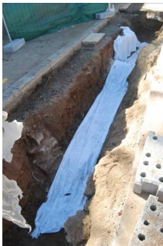
Fotografia núm. 75: cobertura de les estructures amb geotèxtil
