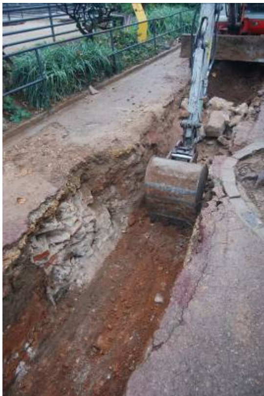
Fotografia núm. 60: desmuntatge de la UE 5003
