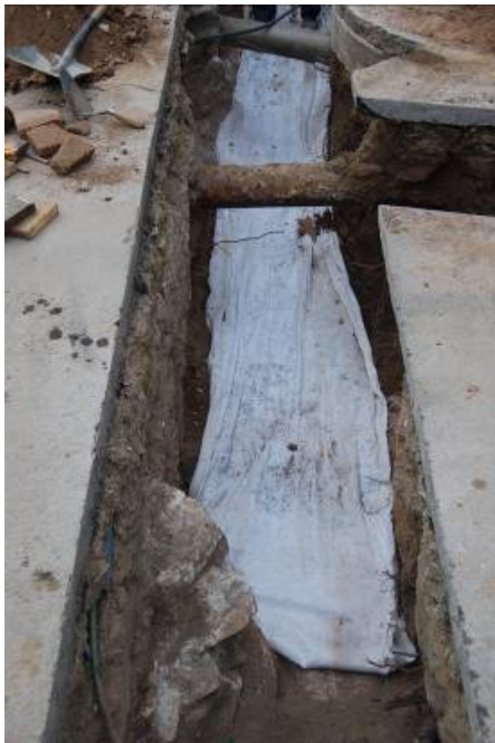
Fotografia núm. 51: cobertura de les estructures a la rasa 4000
