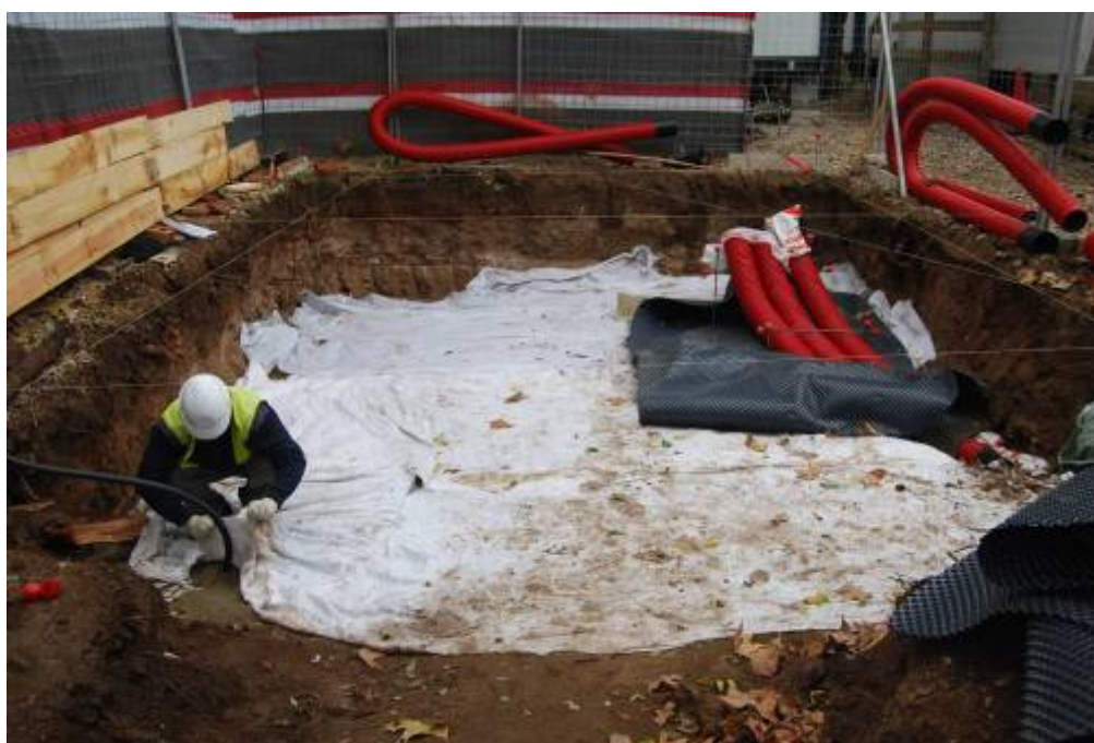
Fotografia núm. 10: cobertura de les estructures amb geotèxtil
