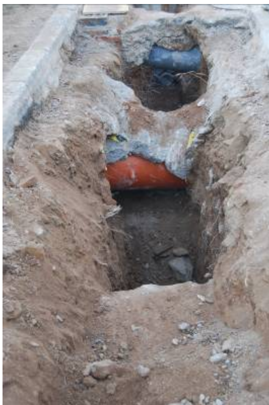
Fotografia núm. 69: vista de la rasa 7000
