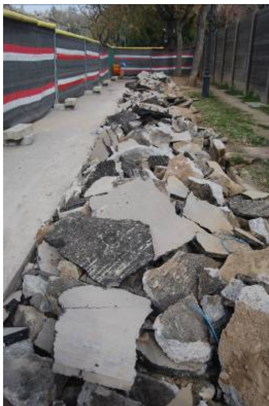
Fotografia núm. 66: obertura de la rasa 7000
