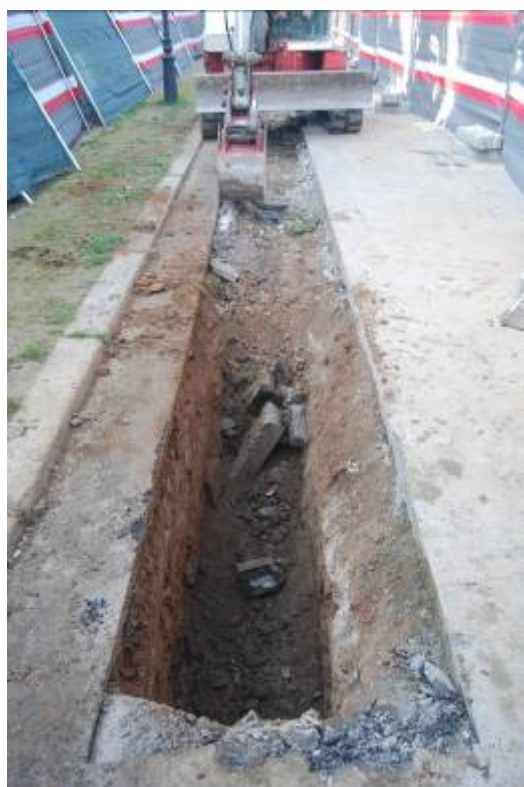
Fotografia núm. 67: obertura de la rasa 7000
