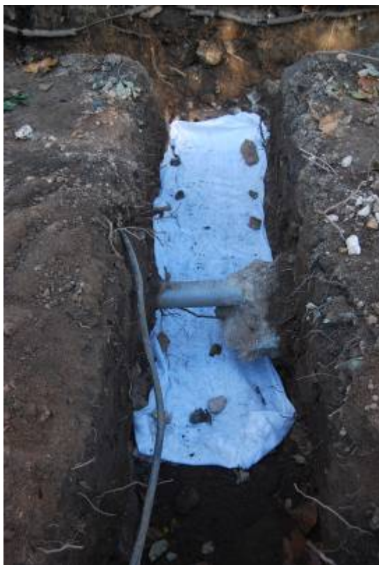
Fotografia núm. 36: cobertura de la UE 604
