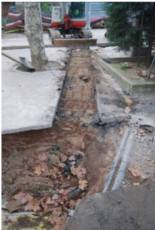
Fotografia núm. 37: obertura de la rasa 4000
