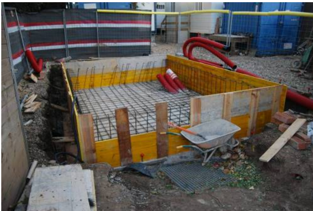
Fotografia núm. 13: construcció de la nova ET
