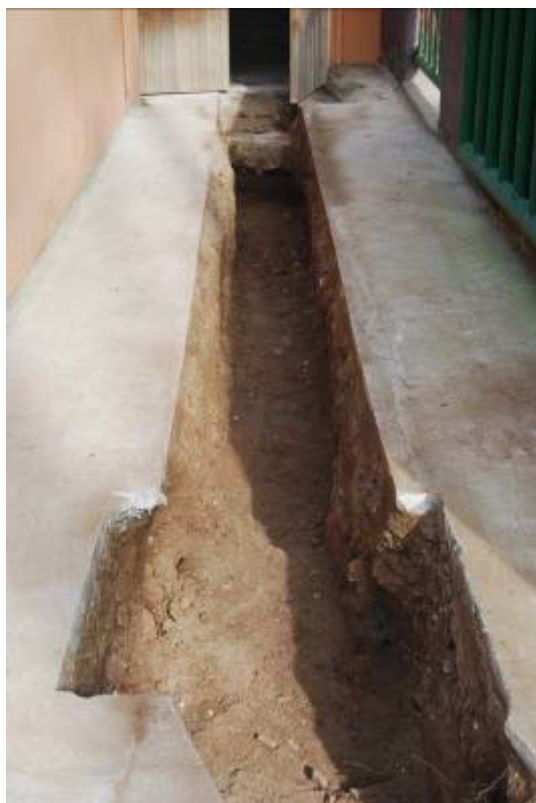
Fotografia núm. 64: vista de la rasa 6000
