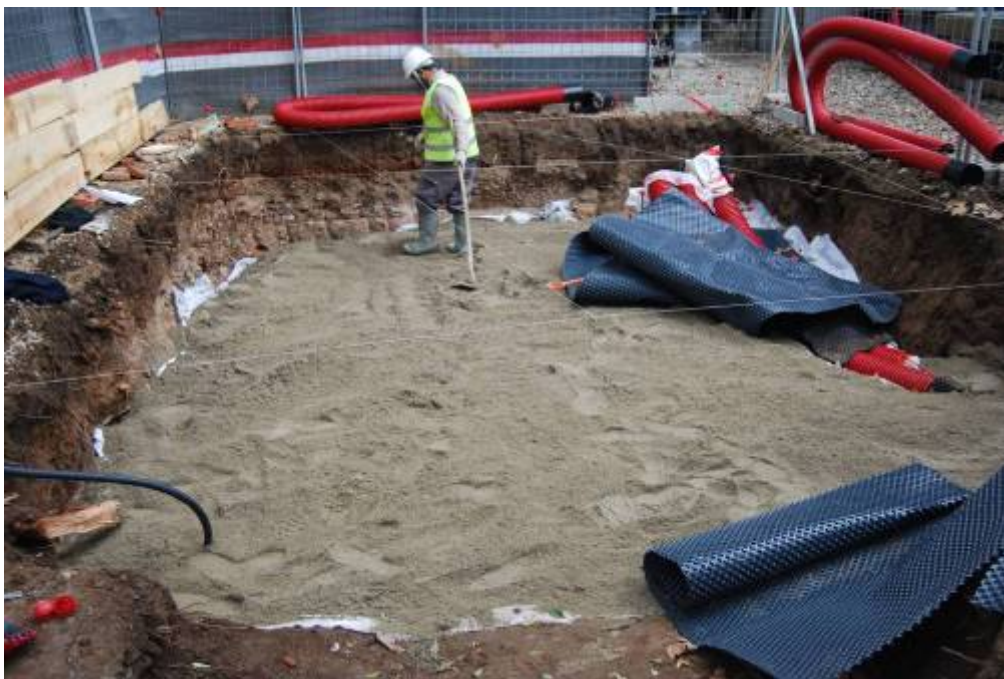
Fotografia núm. 11: cobertura de les estructures amb sauló
