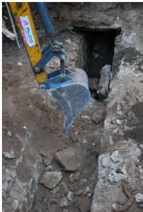
Fotografia núm. 5: desmuntatge parcial de la UE 109
