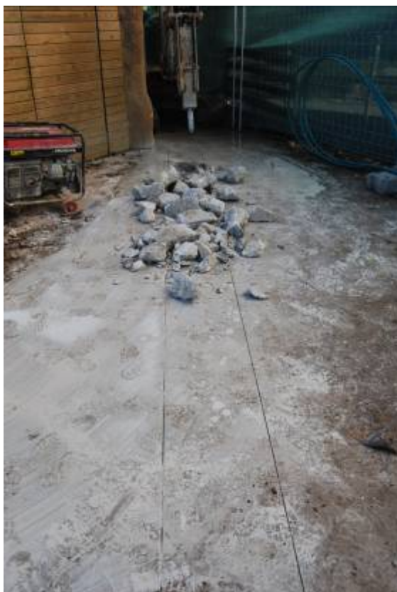
Fotografia núm. 27: obertura de la rasa 2000
