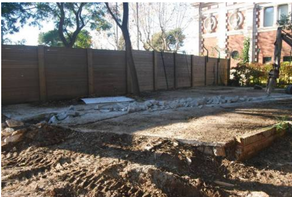
Fotografia núm. 31: obertura de la rasa 3000
