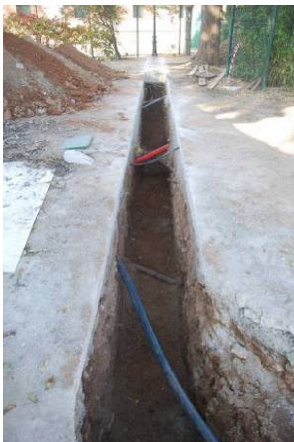
Fotografia núm. 32: vista de la rasa 3000
