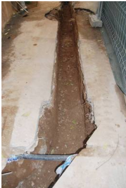
Fotografia núm. 29: vista de la rasa 2000
